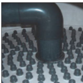
Коллекторная плита с соплами
