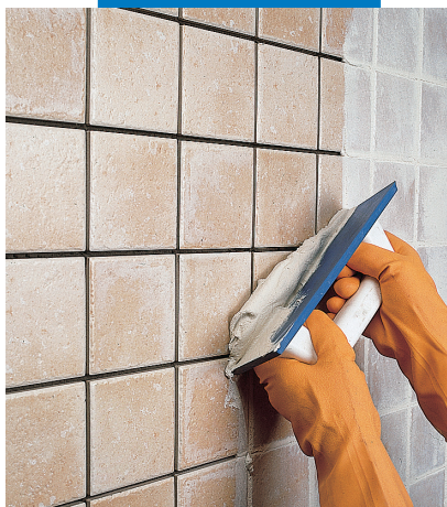
Заделка швов плитки одинарного обжига мастерком
